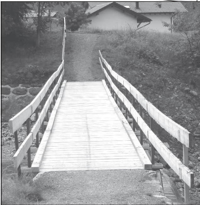
Die Valschavielbrücke in Gaschurn wurde in diesem Sommer von den Mitarbeitern des Bauhofs Gaschurn saniert.
